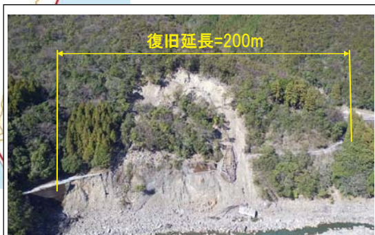
平成26年8月豪雨による大規模地すべりの状況(北川村小島地区)
