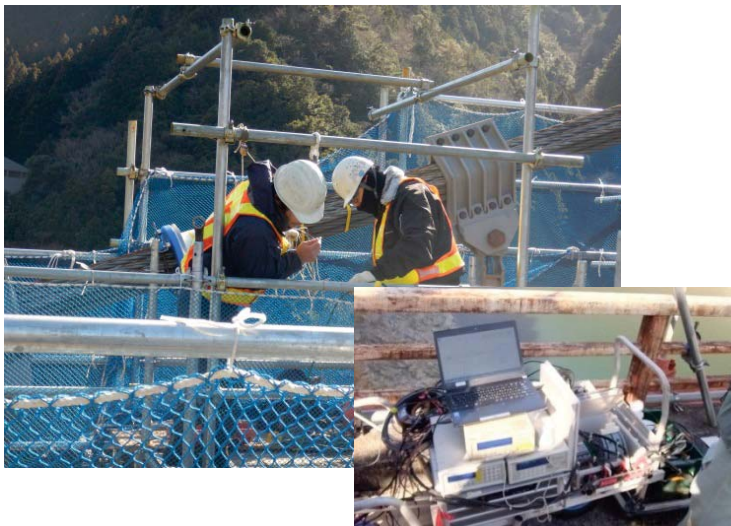
全磁束法による測定状況
