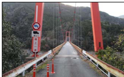
柚ノ木橋現地状況
