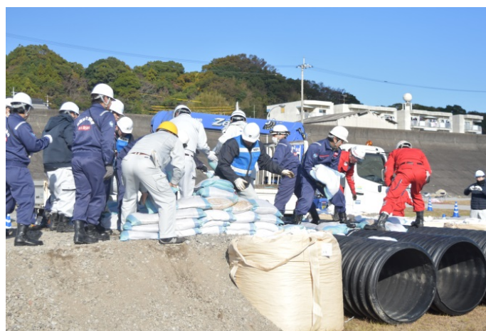
【落橋箇所の応急復旧】
