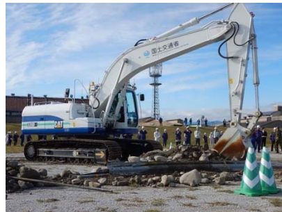
バックホウによるガレキ撤去
