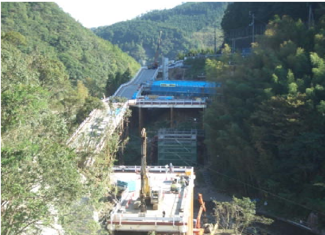
野老山第1 高架橋工事状況写真
