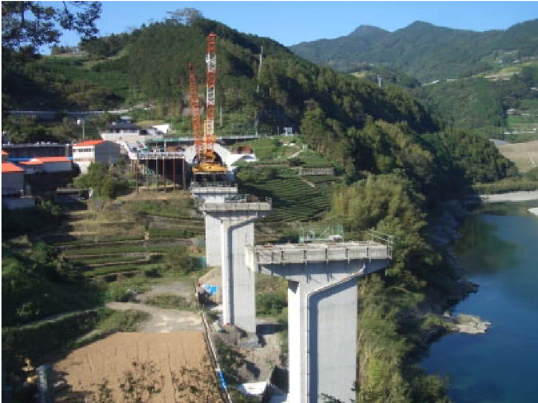
野老山第2 高架橋工事状況写真
