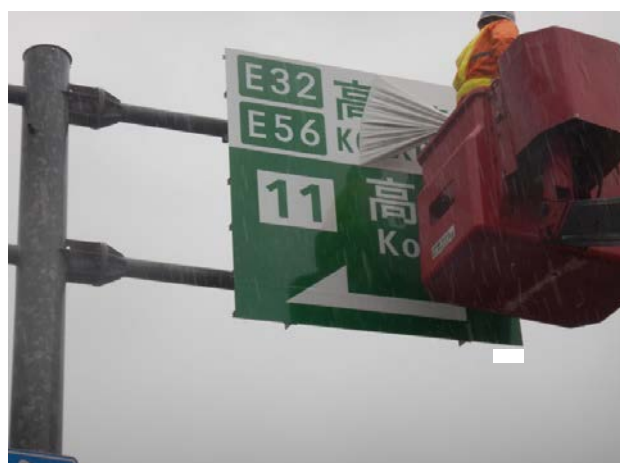
【標識更新作業の状況】
