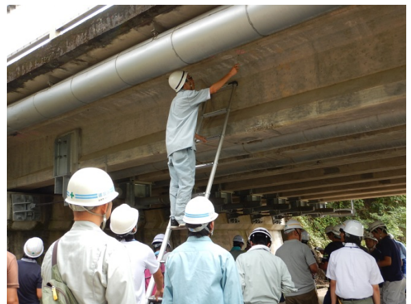
点検実施状況
