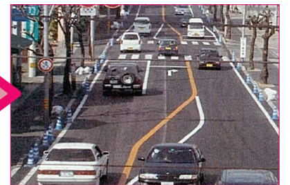
旧道56号(整備後)
