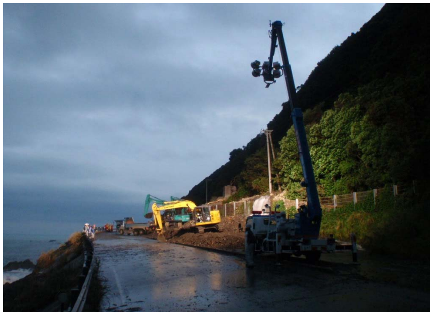
平成27年9月降雨による国道55号通行止(安芸郡東洋町) 照明車(手前)による夜間作業支援状況
