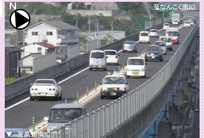
▲【参考】稲生(いなぶ)高架橋の交通状況 H28.4.26撮影
