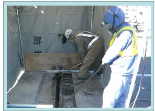
伸縮装置の撤去状況(例)
