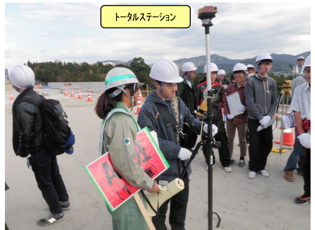
「けんせつ小町」によるトータルステーション出来形管理説明の様子
