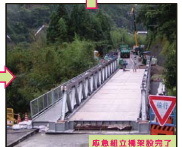
応急組立橋架設完了
