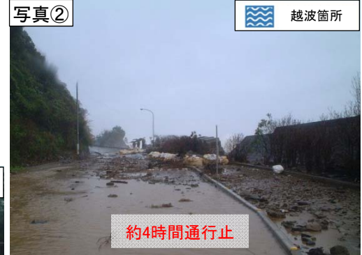
越波・大雨による通行止め(H16.8.30)
