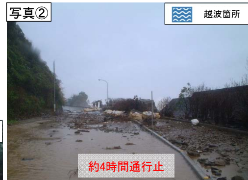
越波・大雨による通行止め(H16.8.30)
