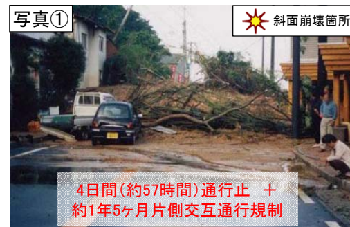
斜面崩壊による通行止め(H10.5.16)
