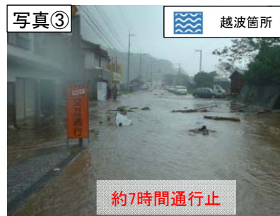
越波・大雨による通行止め(H16.10.20)
