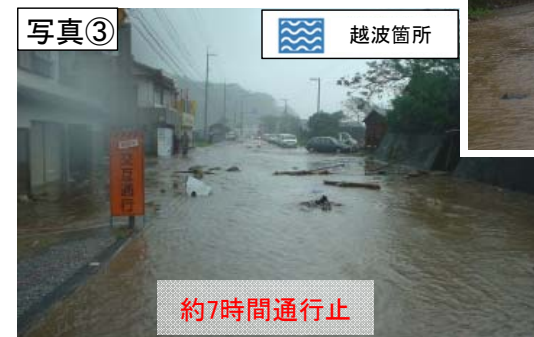
越波・大雨による通行止め(H16.10.20)
