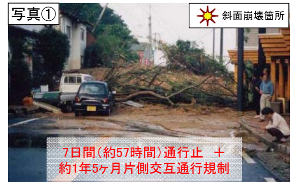
斜面崩壊による通行止め(H10.5.16)
