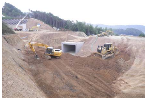
南国市伊達野 (撮影方向: 北向き)
