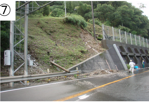
R32 大豊町高須の土砂撤去状況
