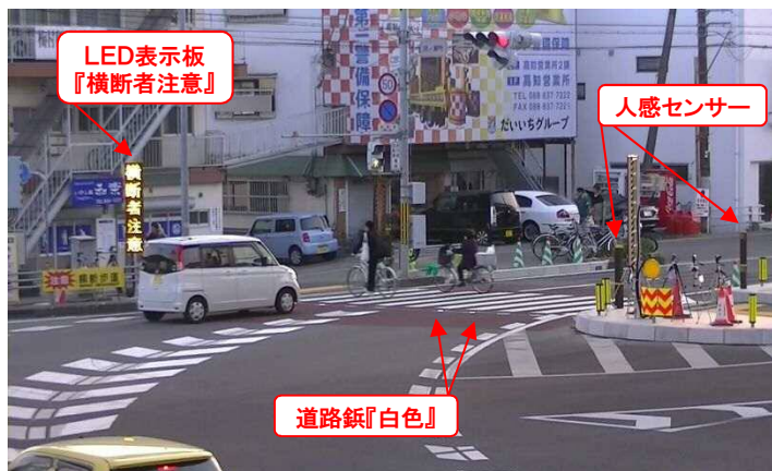
▼横断歩行者・自転車感知式注意喚起システムの設置状況(H26.2.25)
