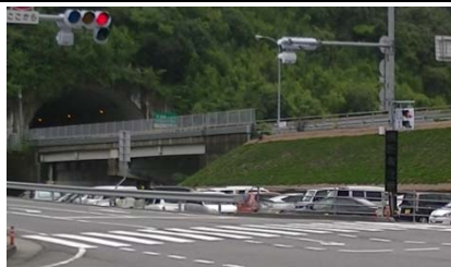
※写真: 国道56号須崎中学校前交差点の注意喚起システム
