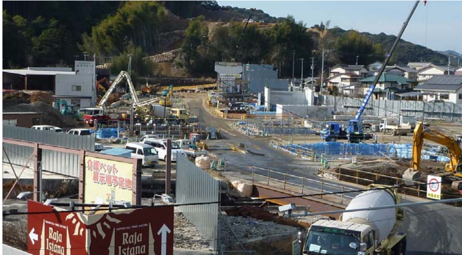
いの町枝川（撮影方向：南西向き）
