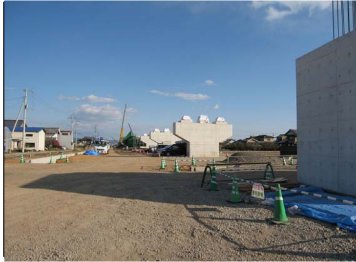
南国市田村（撮影方向：東向き）
