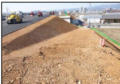
整備中の緊急避難路 (平成26年1月撮影)
