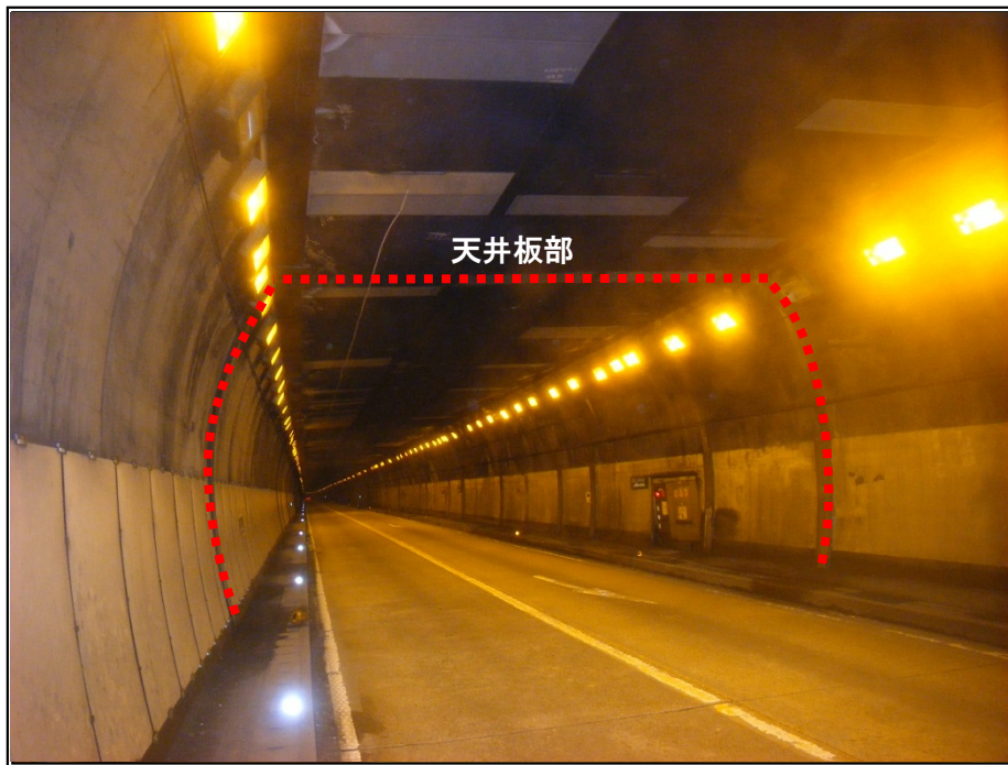
天井板撤去前状況写真
