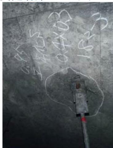
吊金具定着部のコンクリートのうき(19箇所)
