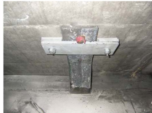
プレートおよびアンカーによる補強状況
