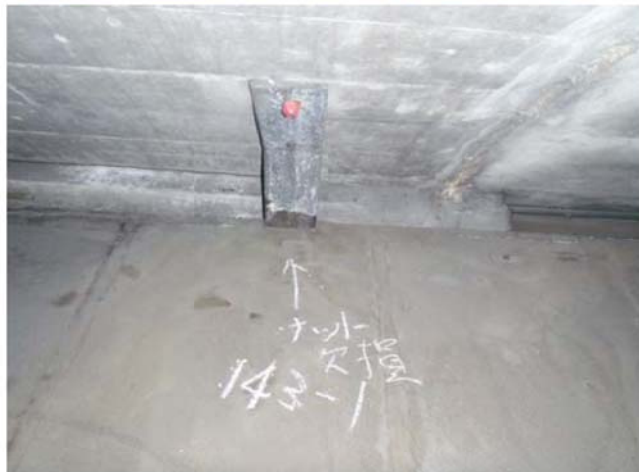
両端支持金具のナットの欠落(23箇所)
