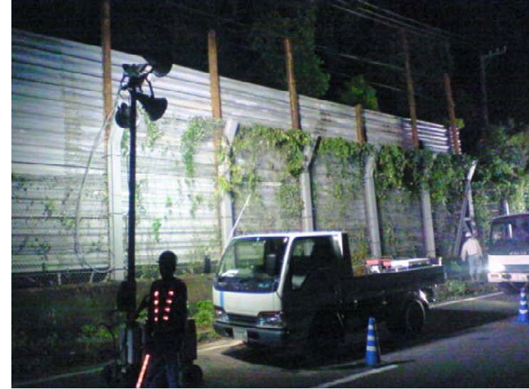
【仮設防護柵設置後】
