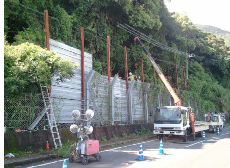
【ガードレールビーム設置】
