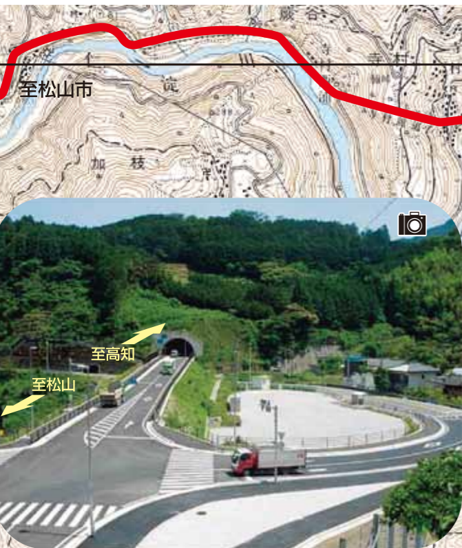
越知道路3工区(野老山地区)平成19年6月9日供用
