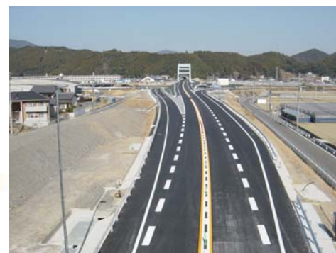
須崎西IC付近 (平成23年2月撮影)
