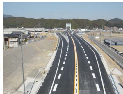
須崎西IC付近 (平成23年2月撮影)
