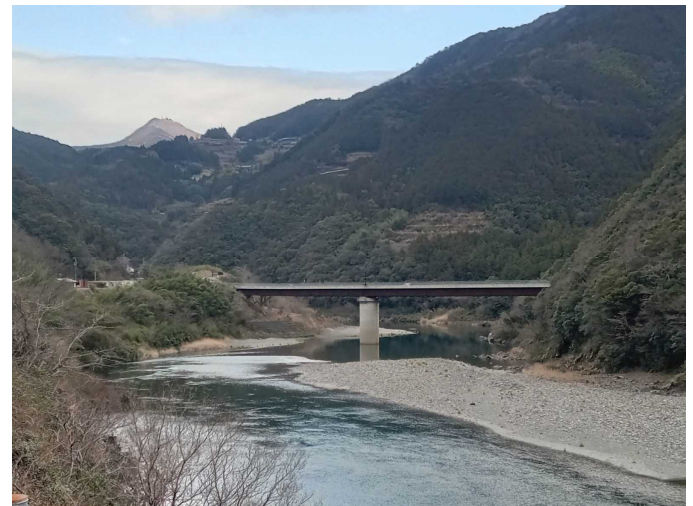
終点側工区（撮影方向：北向き）
