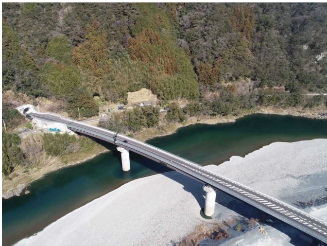
起点側工区（撮影方向：南東向き）
