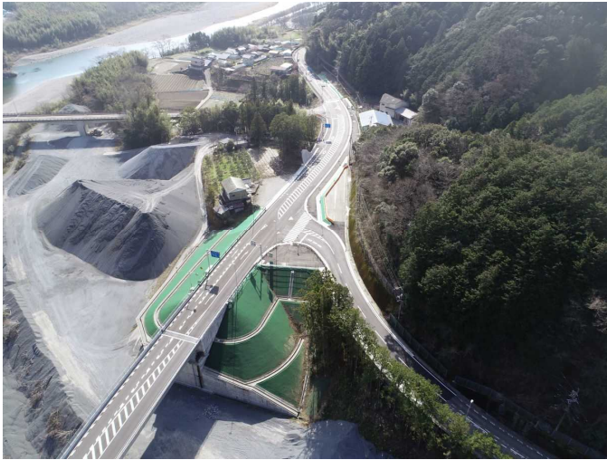
起点側工区（撮影方向：南東向き）
