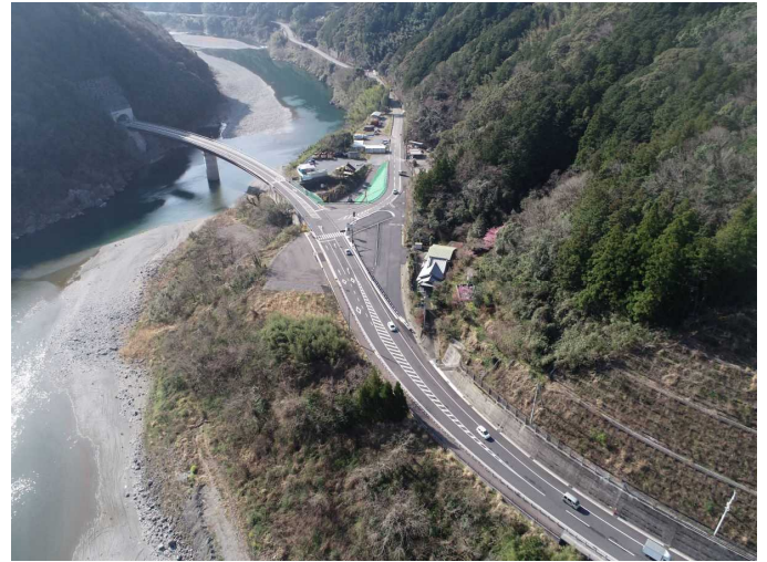
終点側工区（撮影方向：南東向き）
