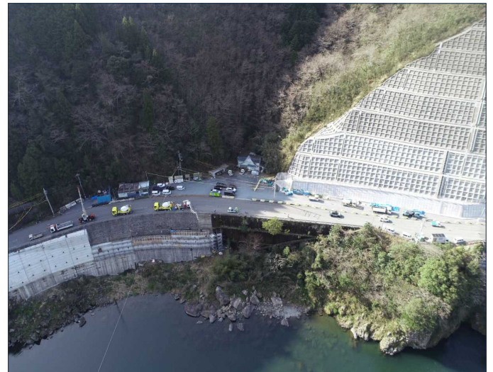
終点側工区（撮影方向：南西向き）
