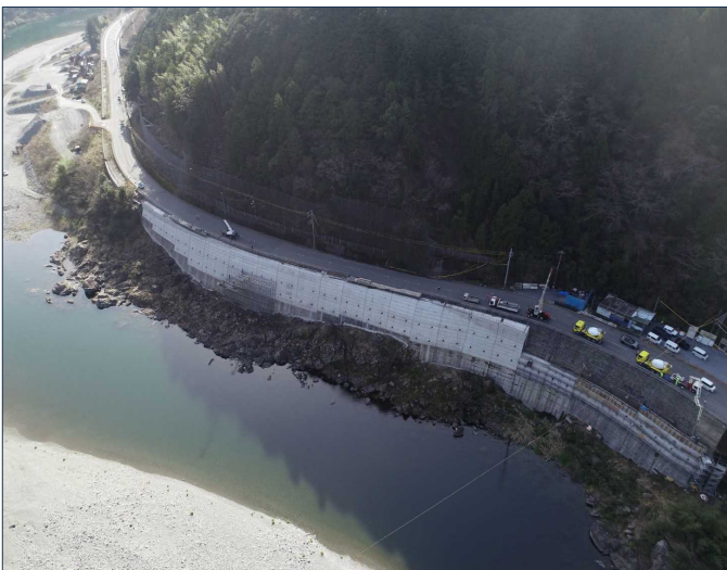
起点側工区（撮影方向：南東向き）
