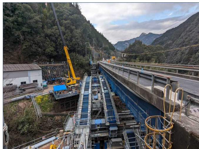
橋の補強工事（下側からアーチで補強）を進めています。
