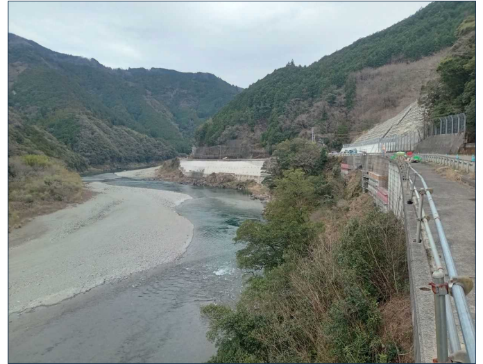
終点側工区（撮影方向：南東向き）
