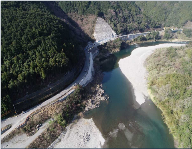
起点側工区（撮影方向：北西向き）
