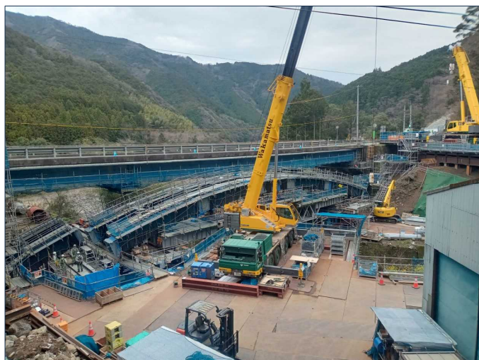
橋の補強工事（下側からアーチで補強）を進めています。
