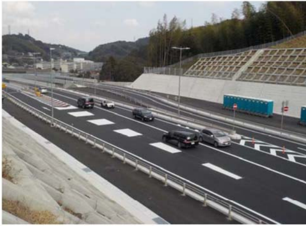
いの町西浦（撮影方向：北東向き）
