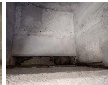
断面修復 (完了)
