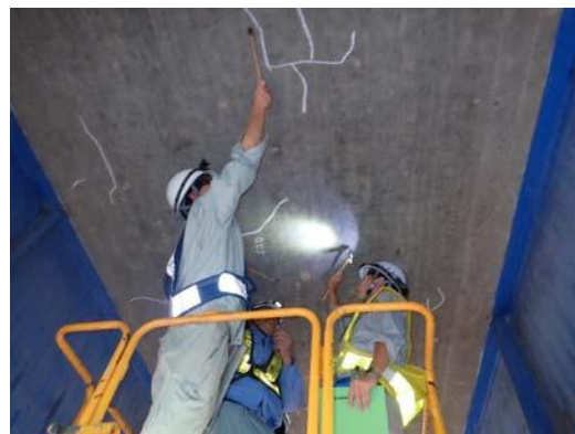
現地実習（リフト車を用いた近接目視点検）
