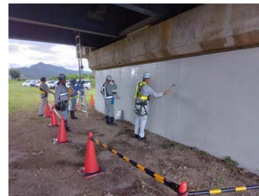
現地実習（下部工点検）
