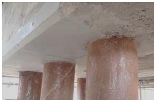
断面修復 (完了)
