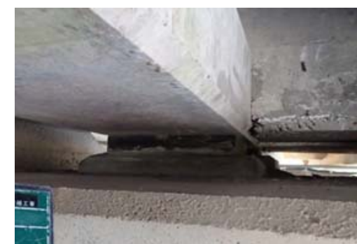
支承部修繕 (完了)
