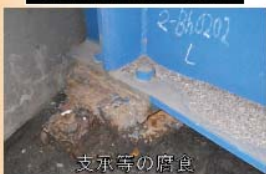
桁端部(上部)の損傷
