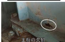
側道橋内部の損傷
