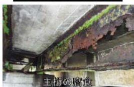
主桁の腐食
