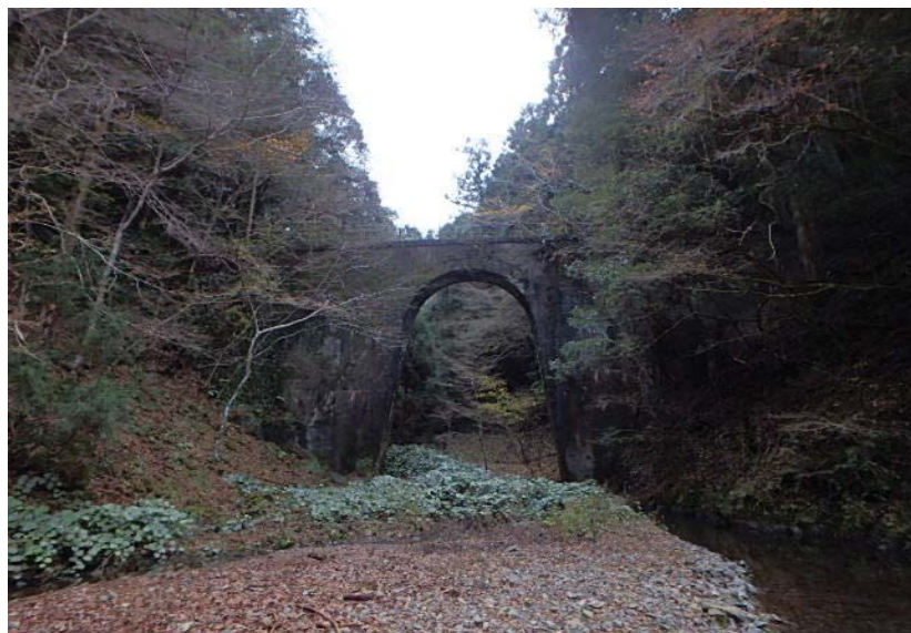
下道下津井1号橋全景
