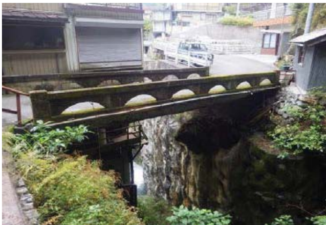
赤根小谷橋全景
