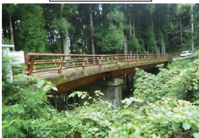
三津子野橋全景
