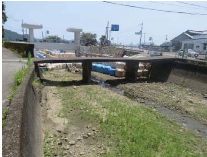
大谷6号線2号橋全景
