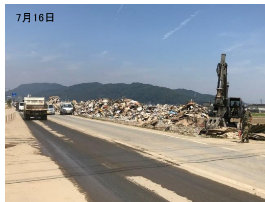
【岡山県倉敷市】 国道486号線付近
