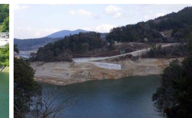
ダム湖進入坂路：須山地区
