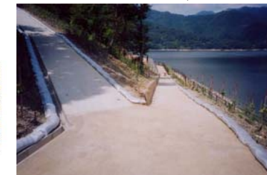
ダムサイト右岸地区
