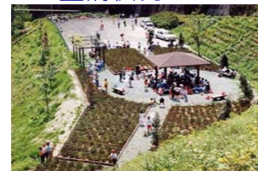
ダムサイト右岸地区
