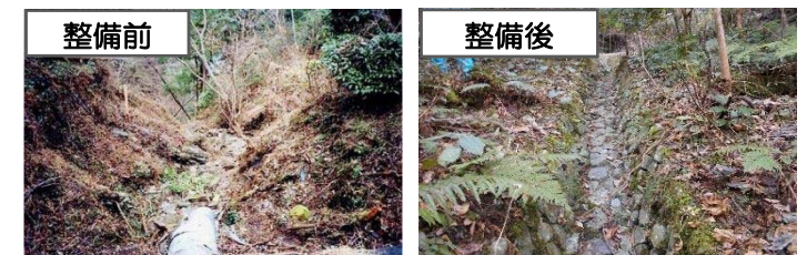
洪水流出で斜面が侵食
