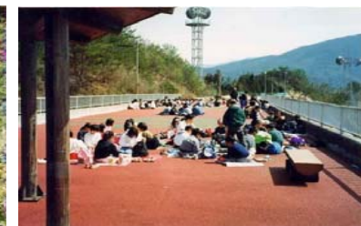
ダムサイト左岸地区
