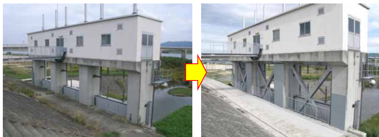
図 3.1.6 前川樋門による地震津波対策
