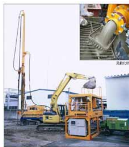
写真：小型重機による密度増大工法の例 1)
