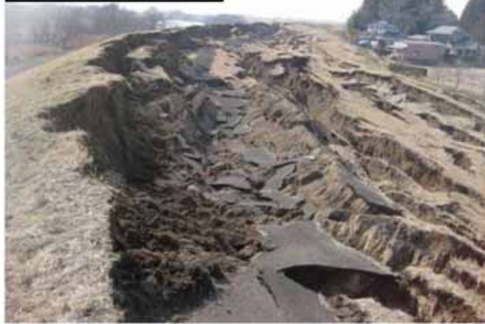
堤体の被災状況 (鳴瀬川：下中ノ目上流地区)
