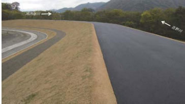
堤防整備(太刀野箇所)【H25完】
