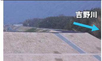
堤防整備(加茂第一箇所)【H25完】
