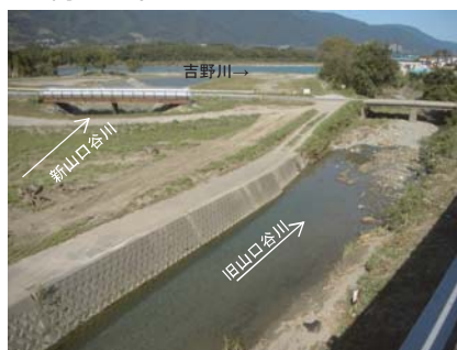
施工前(平成23年)
