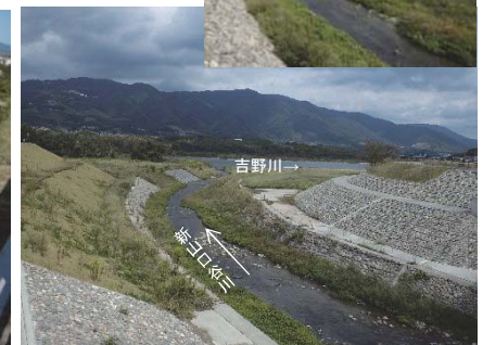
施工3年後(平成27年)
