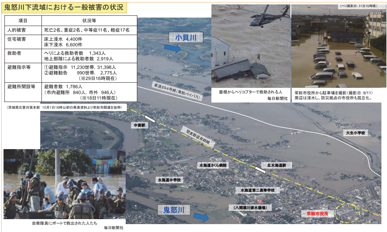
図-4.3.2 鬼怒川の堤防決壊被害状況
