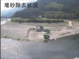
堆砂除去状況
