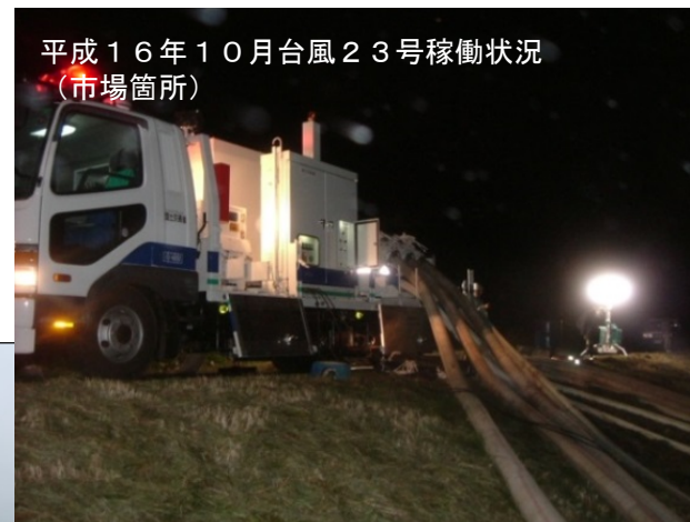
排水ポンプ車、排水施設作業状況
