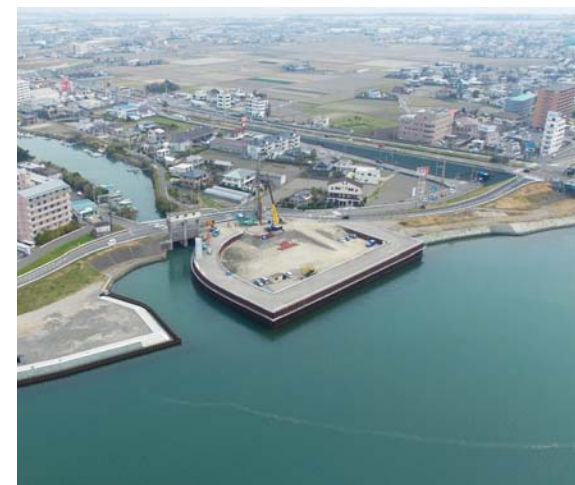
榎瀬川樋門改築
