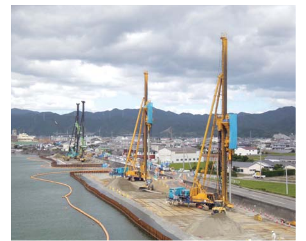
堤防液状化対策
