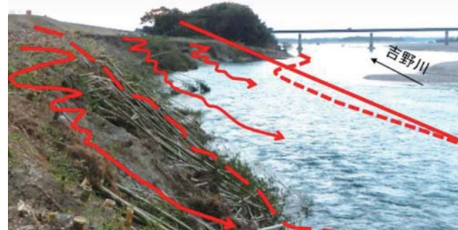
西原箇所(阿波市阿波町)における被災状況
