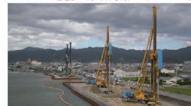
液状化対策（締固め工法）の施工状況（例）
