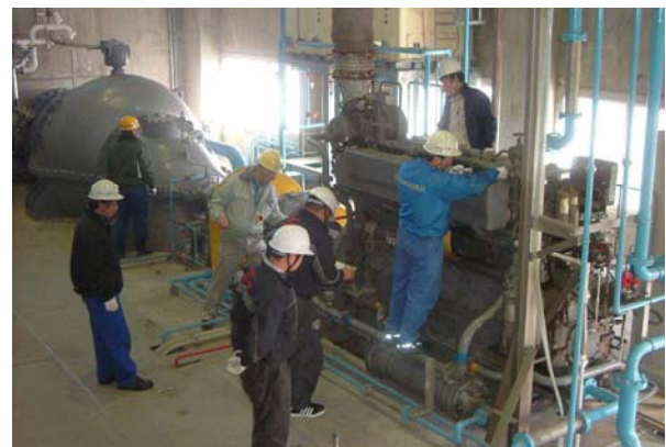
排水ポンプ場（排水機場）の点検
