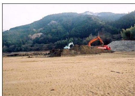
堆砂除去の状況（柳瀬ダム）
