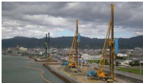
液状化対策(締固め工法)の施工状況(例)
