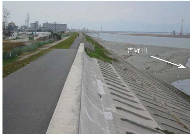
現状の堤防写真
