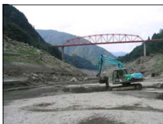
底泥除去（早明浦ダム）
