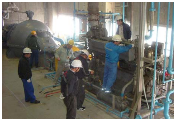
排水ポンプ場（排水機場）の点検
