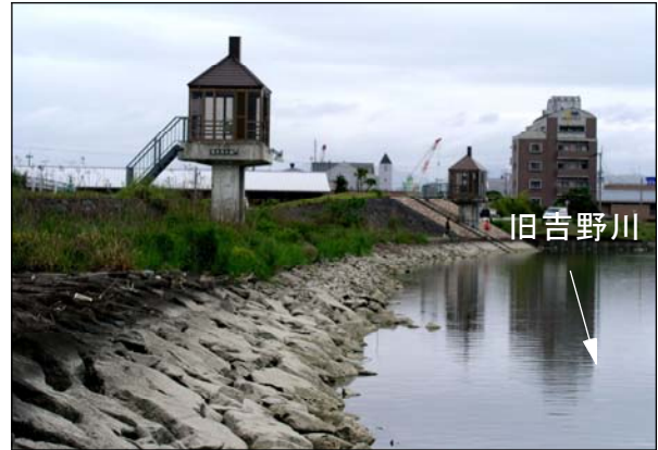
景観に配慮した排水門の整備事例 旧吉野川右岸河口より4km付近
