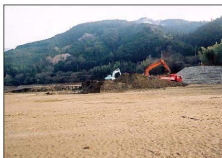
堆砂除去の状況（柳瀬ダム）
