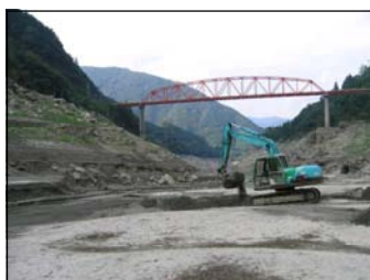
底泥除去（早明浦ダム）
