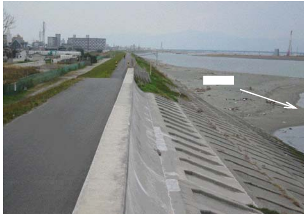
現状の堤防写真
