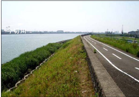
景観に配慮した護岸の整備事例 今切川右岸河口より4km付近
