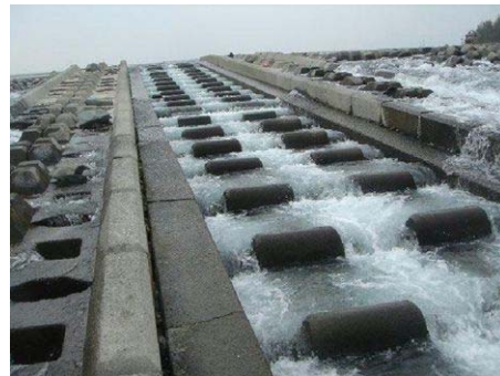
柿原堰の魚道
