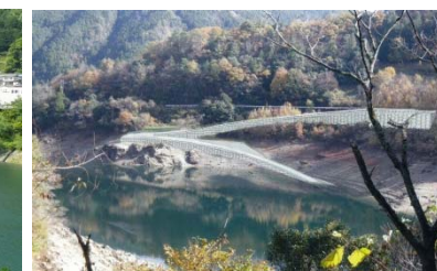
ダム湖進入坂路：須山地区 （写真は完成イメージ）
