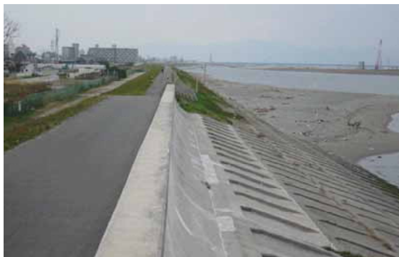
現状の堤防写真
