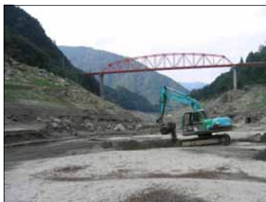
底泥除去（早明浦ダム）
