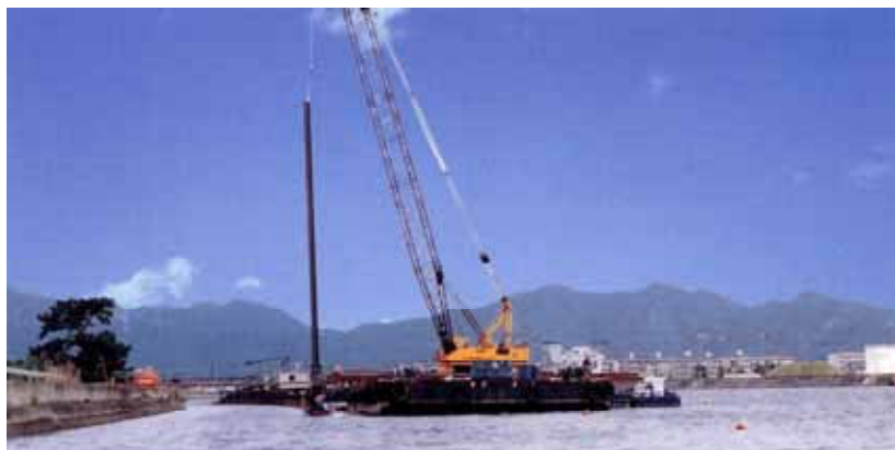
鋼材を用いた工法による耐震対策実施状況
