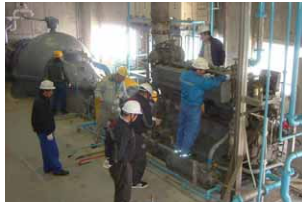
排水ポンプ場（排水機場） の点検
