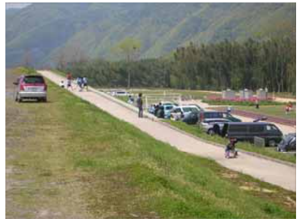
坂路（バリアフリー）の整備事例 吉野川右岸河口より65km付近
