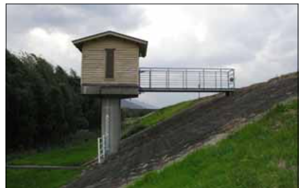
景観に配慮した排水門（樋門）の事例 吉野川左岸河口より37km付近
