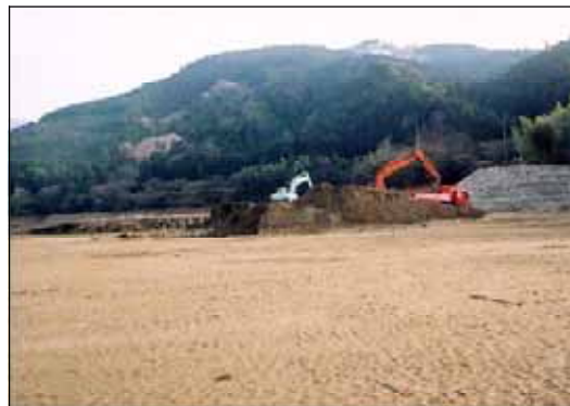
堆砂除去の状況（柳瀬ダム）
