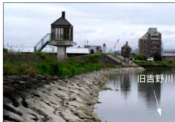
景観に配慮した排水門（樋門）の整備事例 旧吉野川右岸河口より4km付近
